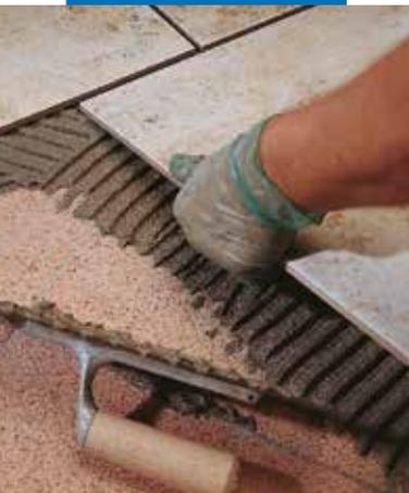
Pose de carrelage en grès émaillé sur carreaux de granito d'un mur extérieur
