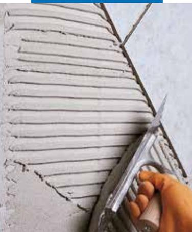
Pose de carrelage au mur, sur béton cellulaire
