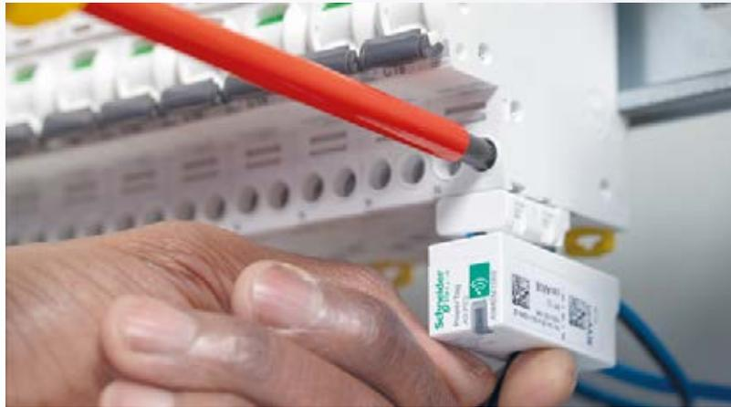
Capteurs d'énergie sans fil PowerTag, à installer en amont ou en aval des produits.
