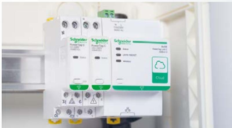
Contrôle commande PowerTag C. Passerelle de communication PowerTag Link.
